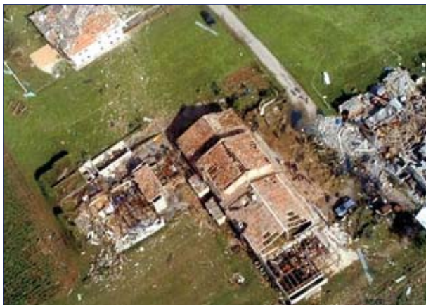
Case e fabbricati distrutti dalla tromba d'aria del 6 giugno
