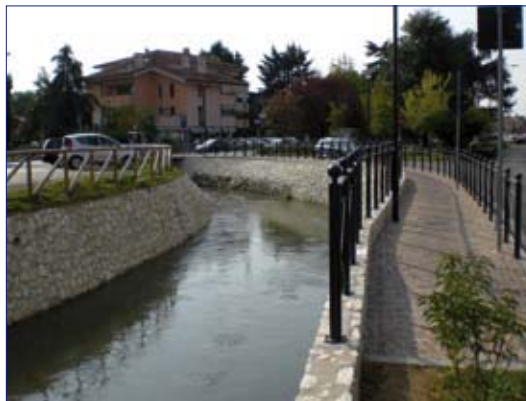
Nuovo argine all'Avenale
