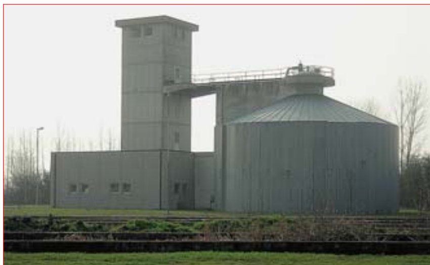
Il depuratore di Salvatronda
