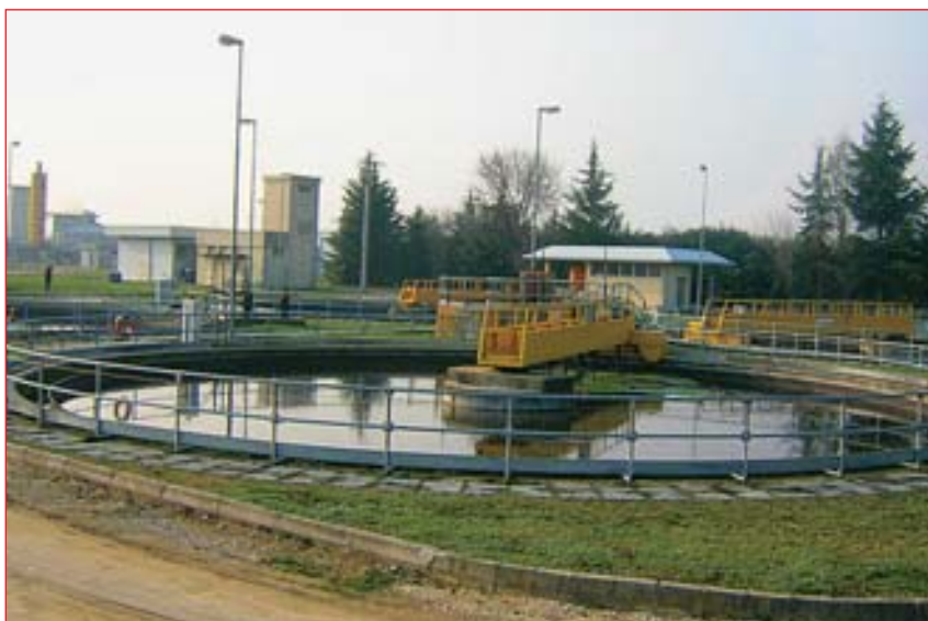
L'interno del depuratore di Salvatronda
